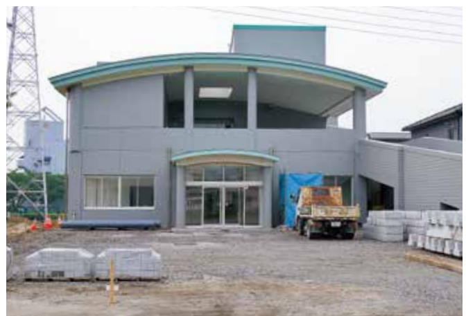
産業会館の外観(工事中)
